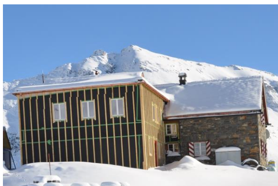
Der neue Anbau beinhaltet im Parterre den Sanitärbereich, im ersten Stock liegt der Hüttenwartzbereich mit eigenem WC. Von der Küche führt ein neues Treppenhaus in Keller und 1. Stock.
