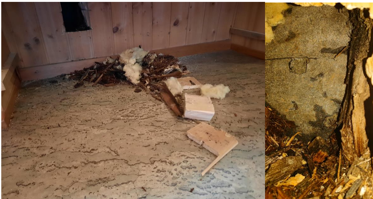
Massive Feuchtigkeitsschäden am tragenden Holz-Ständerbau des 1974-er Anbaus
